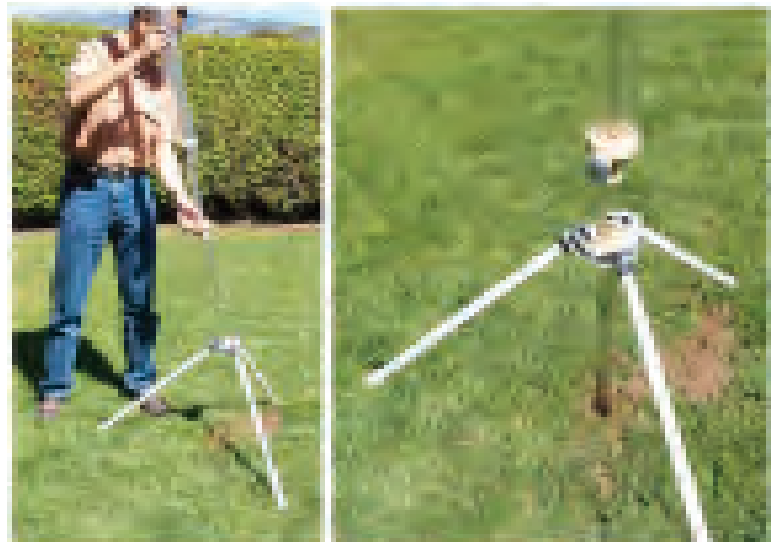
Figura 24. Izquierda: bajando el PG dentro del Trípode y el Pozo. Derecha: El PG se estabiliza empujando el Cojinete del Trípode en la Base del Trípode.
